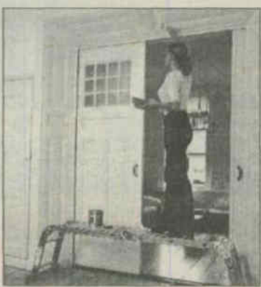
Het ladderbord is ideaal als u langdurig op dezelfde sport van een trap of ladder staat. Bijvoorbeeld bij het witten van het plafond of het monteren van een zoldertrap. Het ladderbord past op elke ladder en is veilig in het gebruik.
